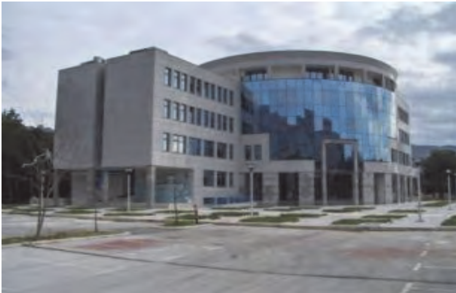
Сл. 5. Управна зграда МХ ЕЛЕКТРОПРИВРЕДЕ у Требињу
